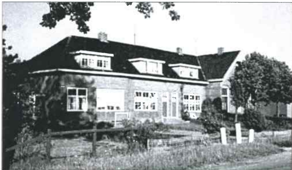
De in 1935 opgeheven openbare lagere school aan het Hoendiep oz te Enumatil, die daarna een woonbestemming kreeg. Afgebroken in 1974 en in 1978 vervangen door vijf woningen
