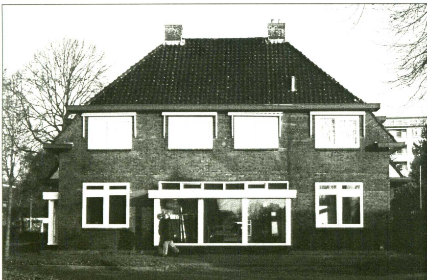
Afb.4 Buitengevel pand in bijna oorspronkelijke staat hersteld . Vergelijk met afb.3
