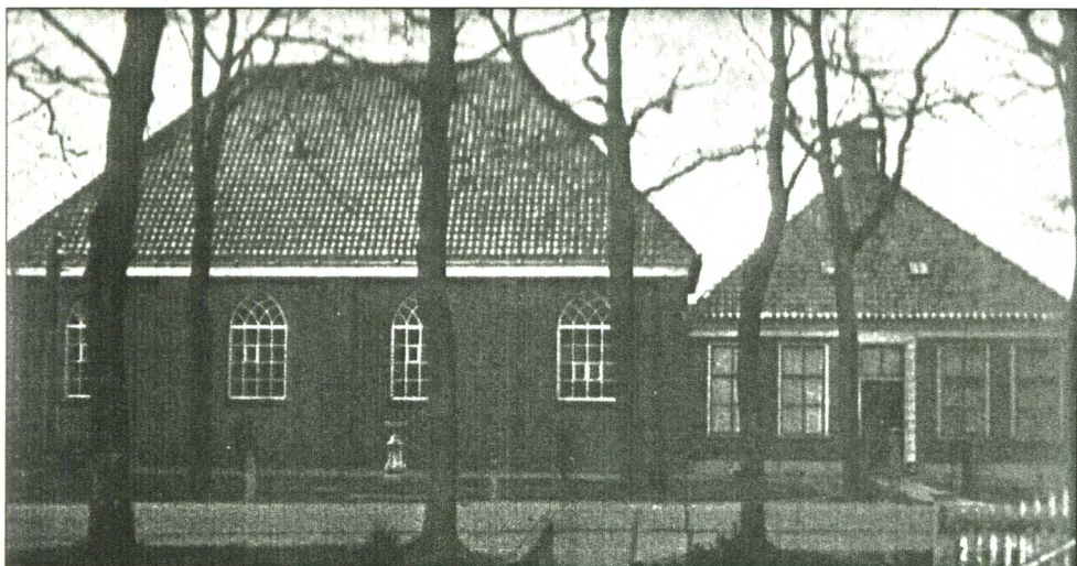
Afb.1 De Rooms-katholieke kerk aan de Gast zoals die er vóór 1929 uitzag
