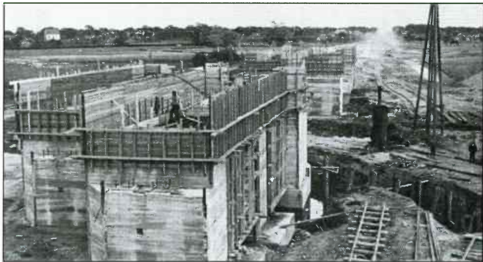
De betonnen brughoofden van de spoorbrug in aanbouw. Aan beide zijden liggen spoorrails voor een stoomtreintje t.b.v. de aanvoer van zand, grind en cement.
