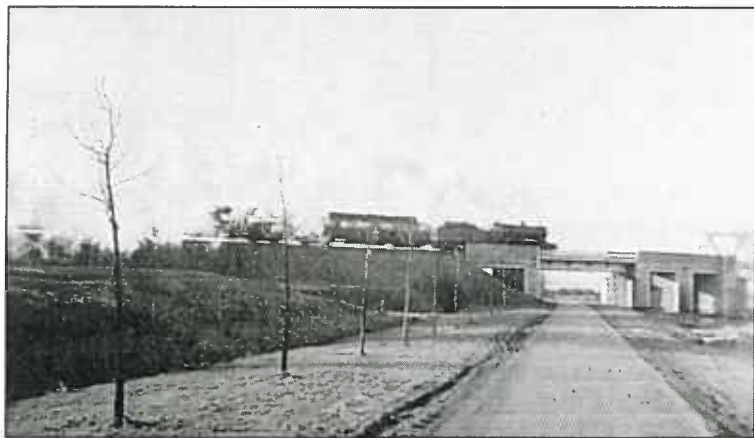
De stoomtrein van Groningen naar Leeuwarden rijdt over de nieuwe spoorbrug van het in 1938 geopende v. Starkenborghkanaal
