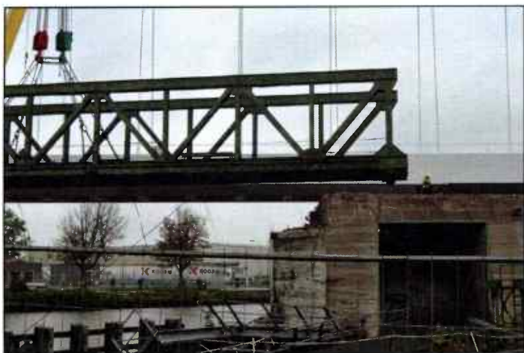
Foto 5. De oude spoorbrug is op zaterdagochtend 7 oktober 2017 met een grote drijvende bok netjes van de bruggenhoofden getild en afgevoerd.
