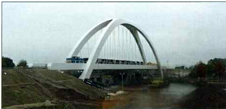
Foto 3. In het weekend vrijdag 29 september tot maandag ochtend 1 oktober werd het spoor over de oude brug afgesloten en de spoorbaan over de nieuwe voltooid. Hier zien we dat er op zaterdag 30 september al een goederentrein over de nieuwe brug reed. Ruim een dag later was de baan al klaar voor testen van de veiligheidssystemen. Dit is een plaatje van de 'Bouwwebcam' van Prorail.
