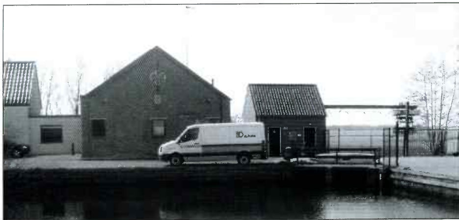
Fig. 3 Het oude machinehuis uit 1879 met rechts daarvan het nieuwe gemaal uit 1991 dat het water uit het Kolonelsdiep oppompt naar het Niekerkerdiep.
