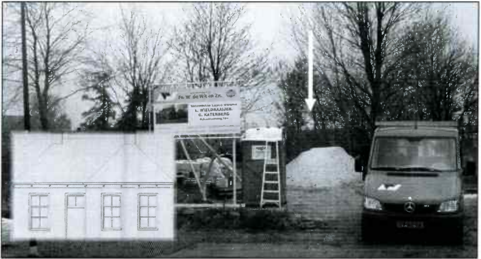
Fig. 4 De bouwrijp gemaakte kavel D grenzend aan het restant van de Noordhorner- tocht, gegraven rond 1640 (witte pijl). Op de bouwplaats is het vooraanzicht van het oude tolhuis geprojecteerd.
