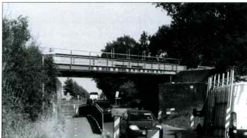
Hetzelfde viaduct gezien vanuit Zuidhorn, met de situatie in augustus 2018. Een apart fietspad links en een drukke rijbaan. Drie maanden later is dit allemaal gesloopt en vervangen door een nieuw viaduct, geschikt voor dubbelspoor.
