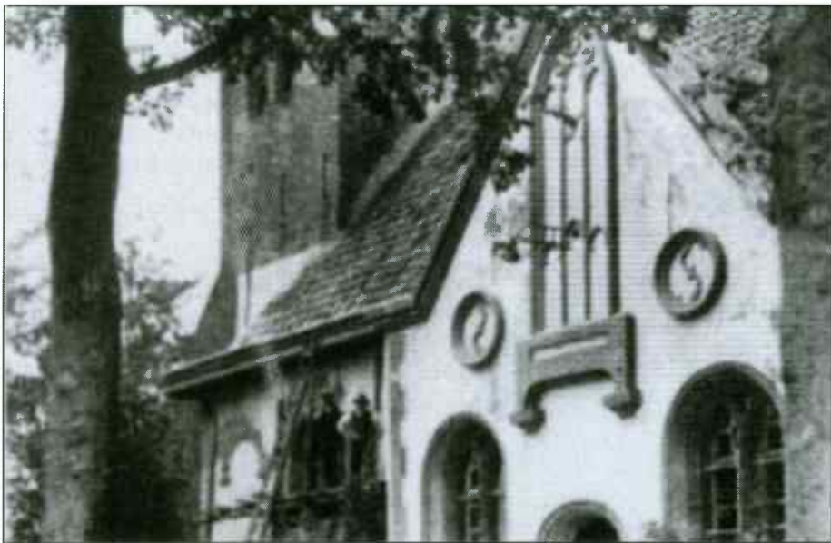
Foto gemaakt tijdens de werkzaamheden in 1931. Een van de twee personen op de steiger is misschien aannemer Postema (met hoed)
